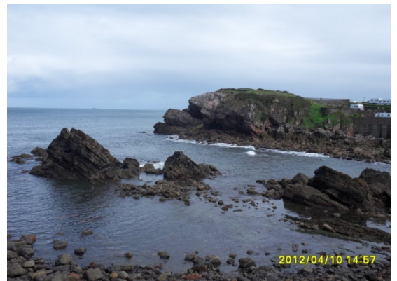
Vue du remblai de Candas
